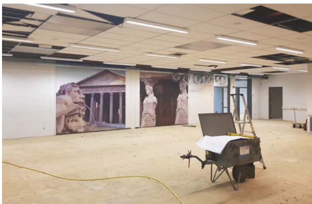
Start van de verbouwing van de voormalige studiezaal: alleen de klassieke 'muurschilderingen' zijn nog herkenbaar
