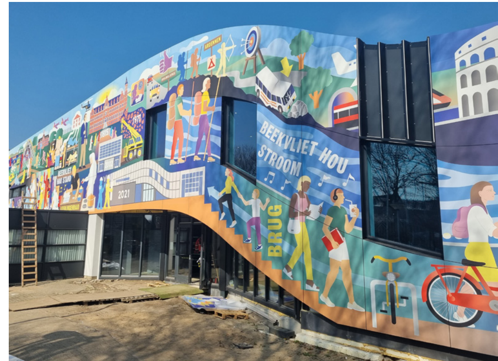
De nieuwe buitengevel ter hoogte van de ingang. Eén plaat ontbreekt nog...
