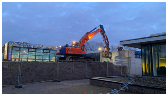
De start van de sloop van het sciencelokaal, meteen na Kerst
