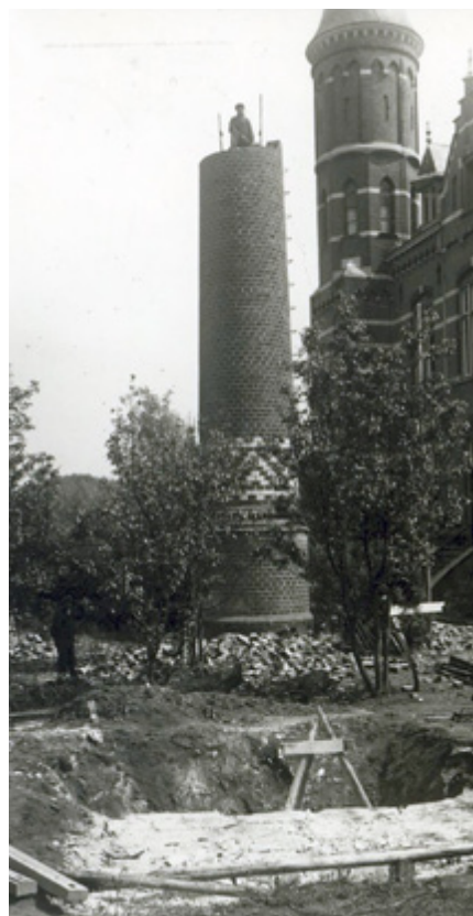
▲ De bouw van de schoorsteen in 1931. Foto BHIC.
